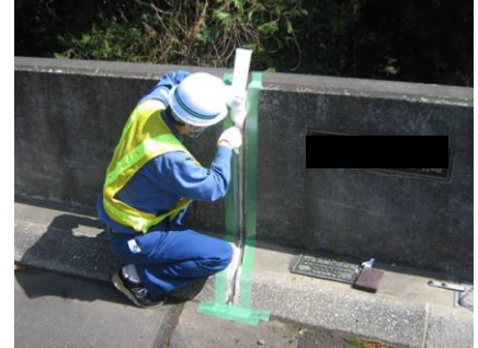
軟質ウレタン材等を遊間部に挿入。シーラ深さが一定になるように位置を決定し固定する。
