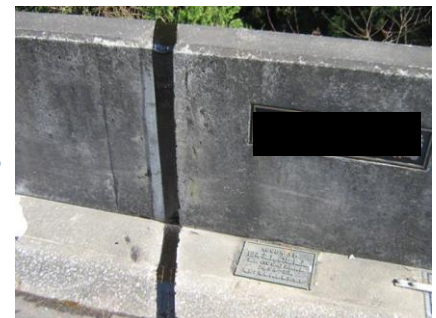
スカイシーラ F-2 充填施工完了。
