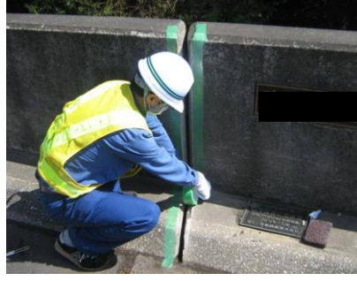
養生テープにてシーラ塗布部の際を養生する。 (写真では研磨ブラシで塗布面の下地調整も行った)
