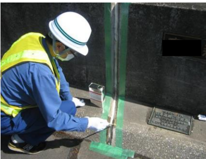
コンクリート面等付着面にプライマー-Uを原液にて塗布する。(塗布量 0.1kg/m 2 目安)
